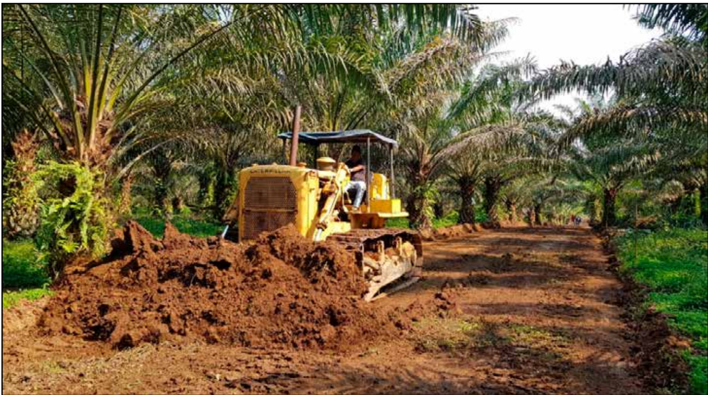
Foto 2. Apertura de caminos instalaciones de palmeras. Ubicado en la parroquia San Roque, cantón Shushufindi, provincia de Sucumbíos, Amazonía ecuatoriana. Fotógrafo: Nicolas Mainville
